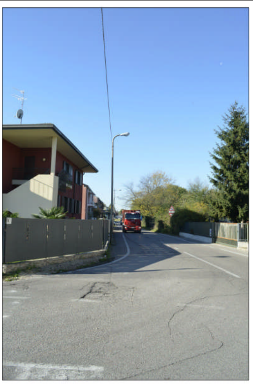
FOTO 13 - vista via Cason da incrocio tra via Carnia, via Cason e via Brigata Aosta
